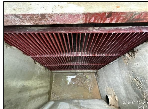
ภาพที่ 34 ตะแกรงดักขยะบริเวณบ่อพักน้ำ
